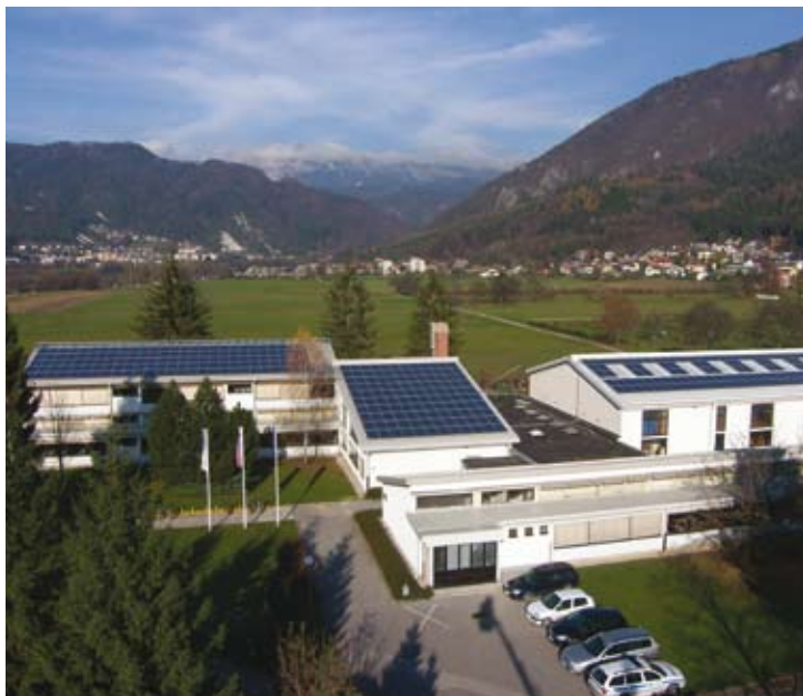
Sončna elektrarna Križe, postavljena na strehi objekta OŠ Križe
