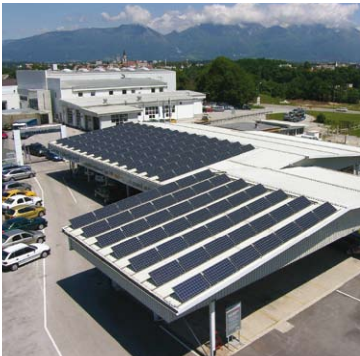
Sončna elektrarna Labore , postavljena na strehi objekta A1-Remont Labore
